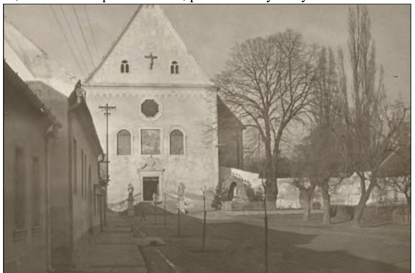
Plocha pred kláštorným kostolom s lípou zachovanou dodnes, 40. roky 20. storočia. Stav pred prepojením Holubyho ulice s Kupeckého.
