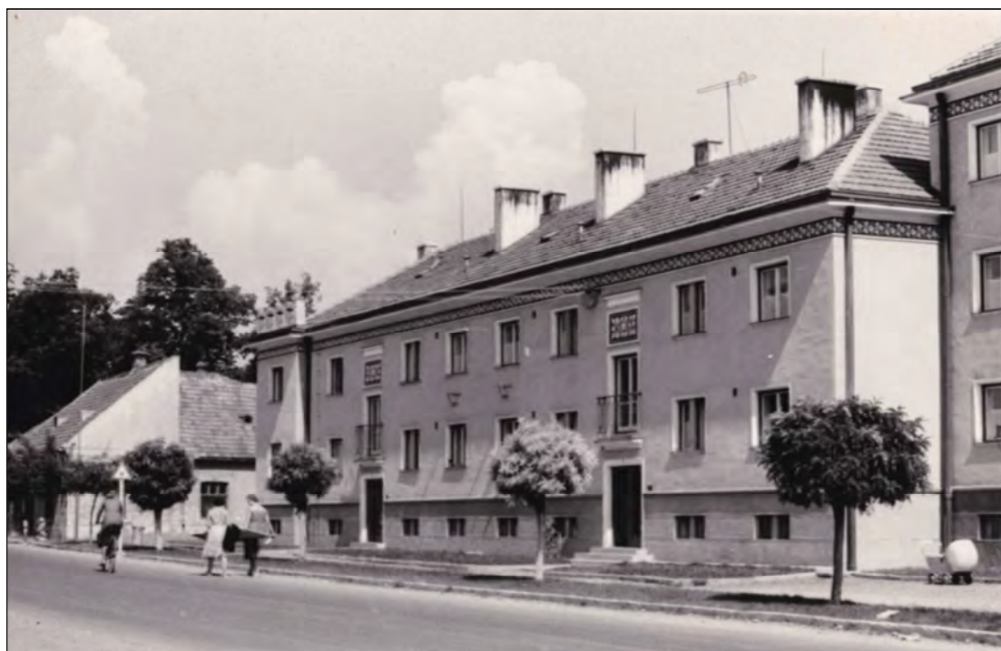
Nová bytová výstavba na Štefánikovej ulici na mieste evanjelického cintorína, 1960.
