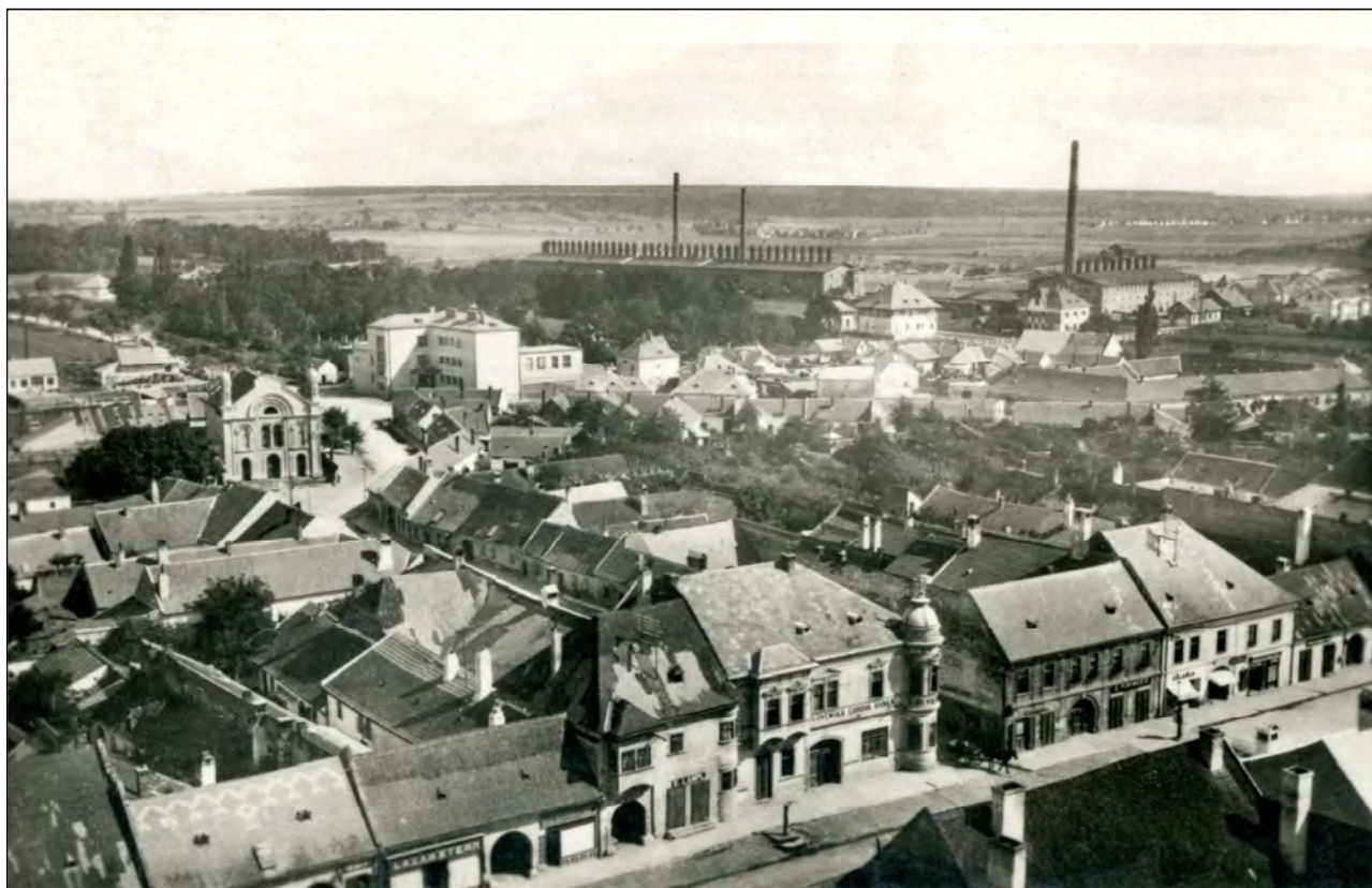
Historický pohľad z veže Evanjelického kostola na pôvodnú zástavbu Štefánikovej ulice, 1. polovica 20. storočia.
