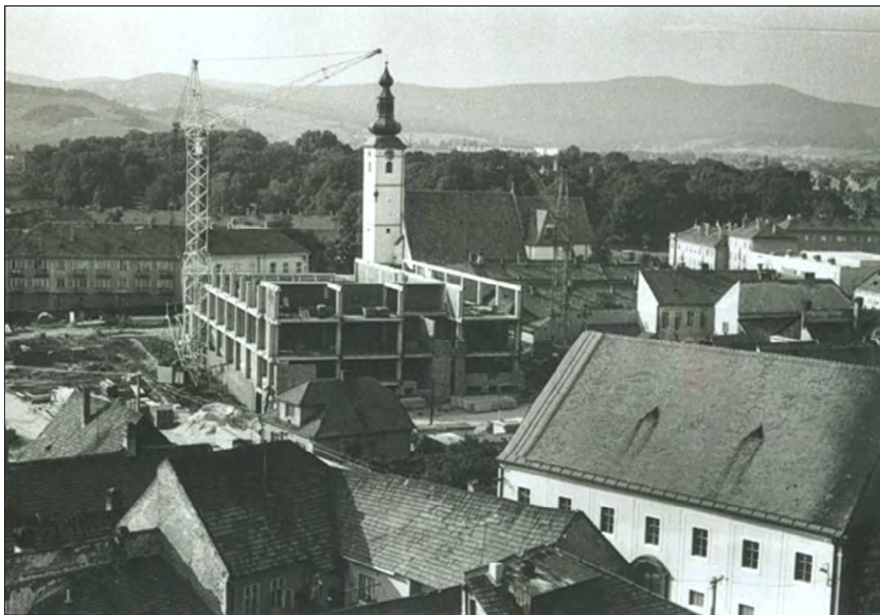
Výstavba Kultúrneho domu v 80. rokoch 20. storočia.
