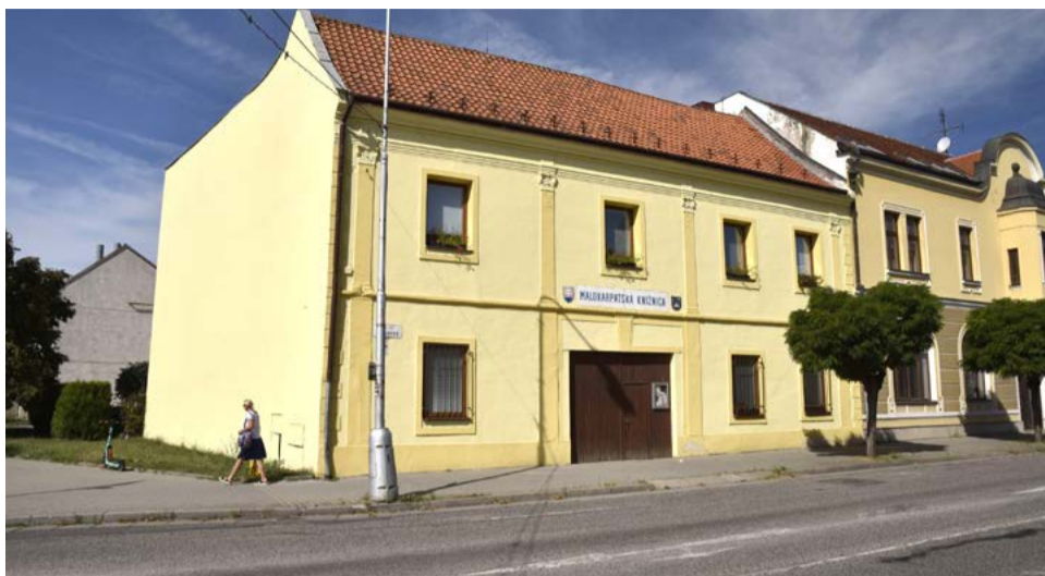
Budova Malokarpatskej knižnice s redukovanou klasicistickou výzdobou
