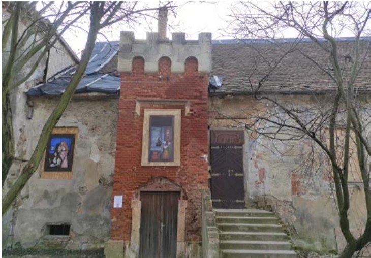
Zadebnenie otvorov hlavnej budovy zdobia výtvarné diela
