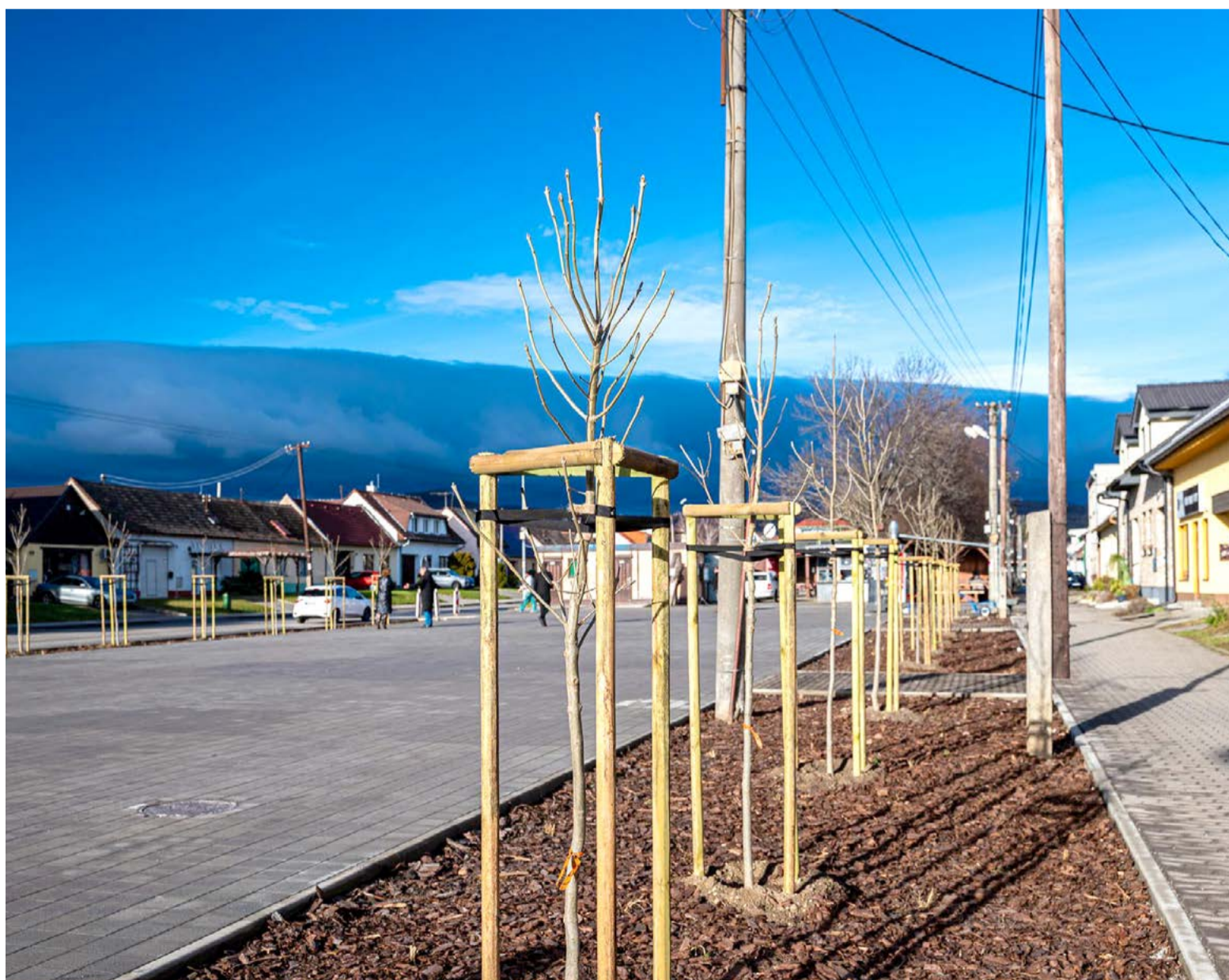
V závere roka ukončilo mesto stavebné a revitalizačné práce na Kupeckého, Malokarpatskej a Zámockej ulici
