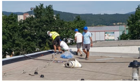
Oprava strechy na ZŠ Fándlyho
