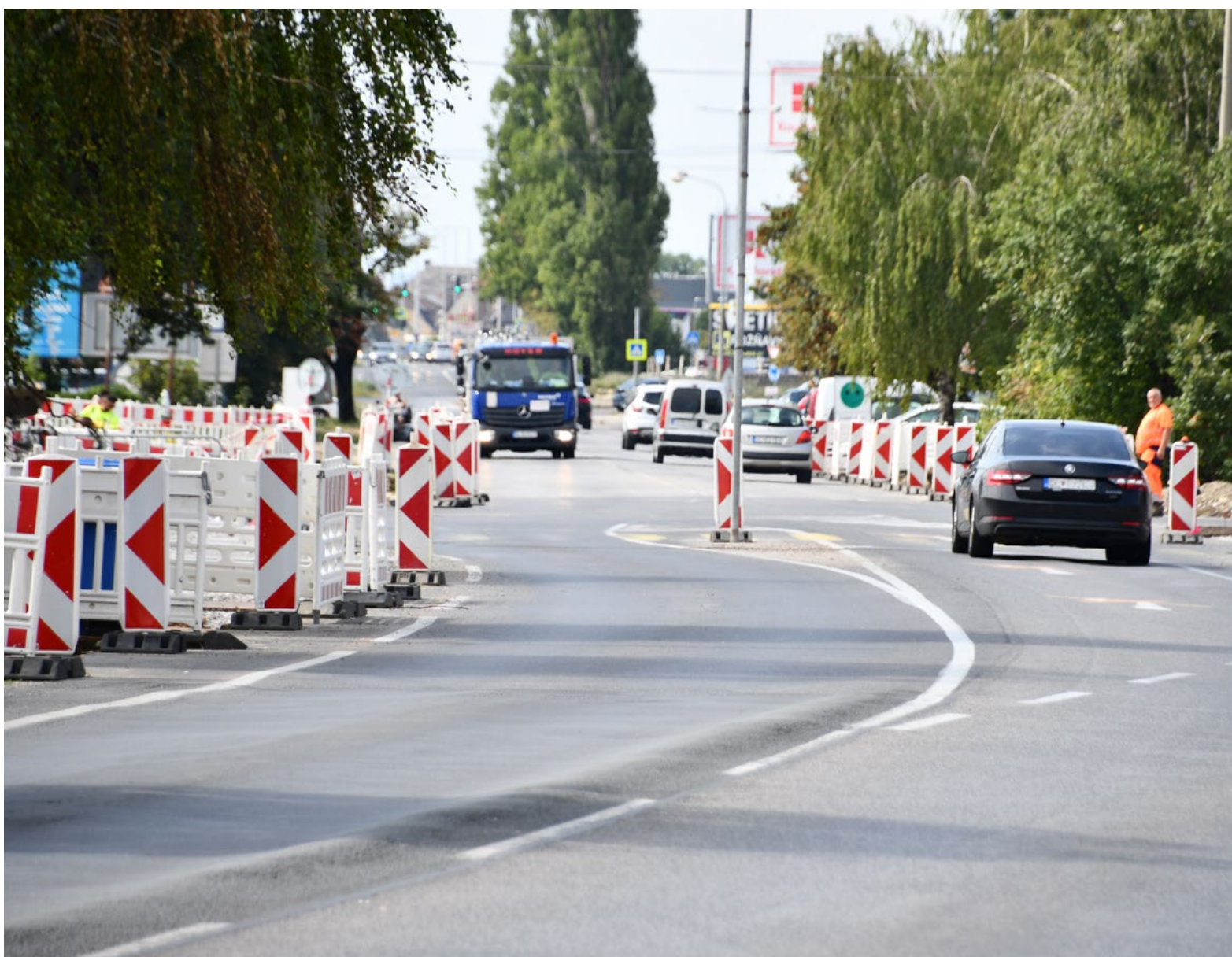
Rekonštrukcia cesty na Bratislavskej ulici je v závere
